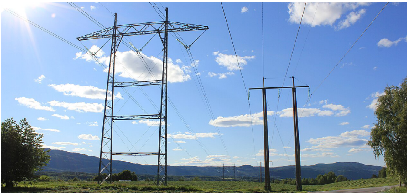
Figur 7: Høyspentmaster, til venstre en mast tilhørende transmisjonsnett og til høyre tilhørende regionalnett.
