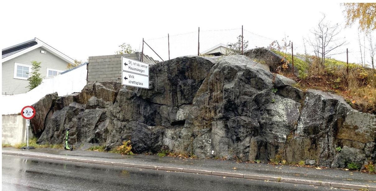
Figur 8: Eksisterende skjæring nord for Kjellbergveien.
