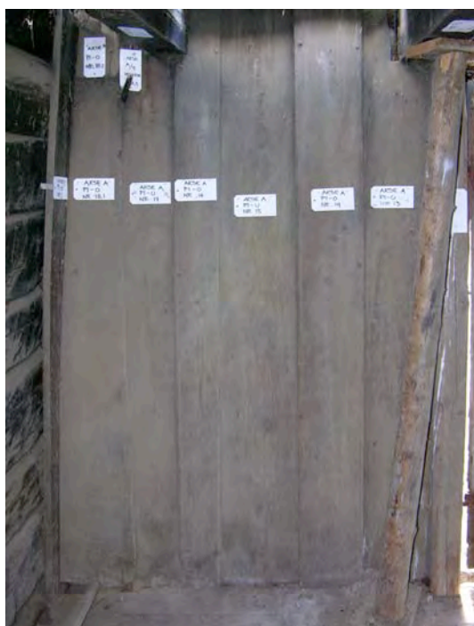
Innvendig kledning på yttervegg akse A i stuen, ved deleveggen til forgangen
