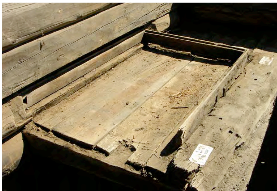
Bordet med hvit lapp, er det samme takbordet som er avbildet under til høyre
