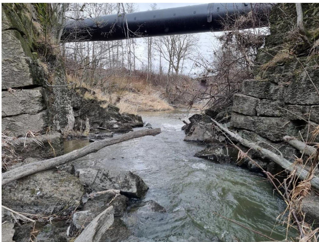
Figur 25. Tiltaksstrekningen og stein/blokksubstratet i brukrysningspunkter som likner godt elvemusling og fiskehabitat. Sammenlignet med bildene ovenfor (Figur 16-22) som viser et mer naturlig elveløp i en slik ravinebekk.
