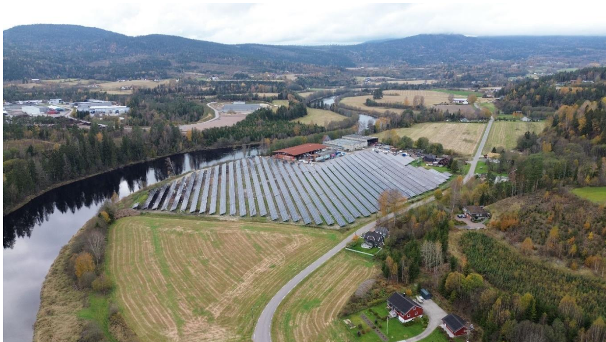
Foto: Greenstat. Engene solkraftverk i Larvik kommune. Vestfolds første bakkemonterte solkraftverk som settes i drift første kvartal 2025.
