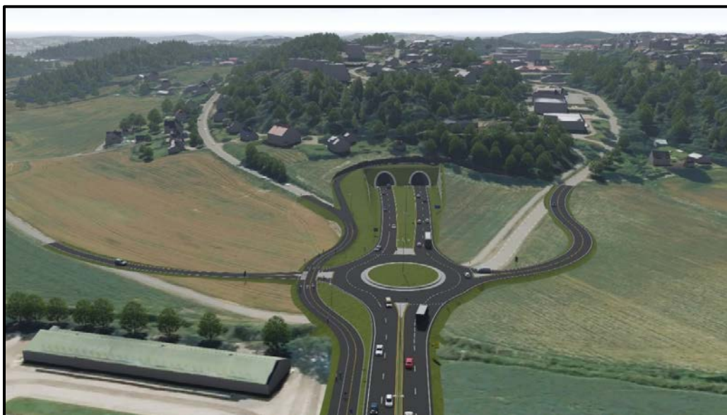
Figur 11: Tunnelpåhugg ved Hogsnesbakken for «Ny fastlandsforbindelse fra Færder».
