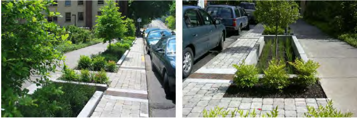
Figur 17: Eksempel på lokal overvannshåndtering langs veg
