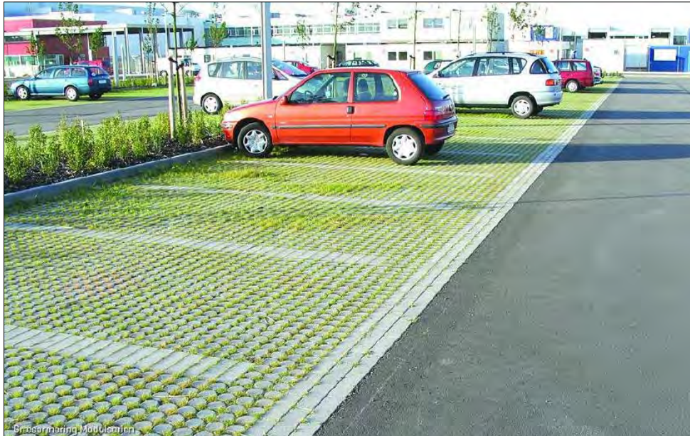
Figur 18: Eksempel på kjørbare arealer med infiltrasjon
