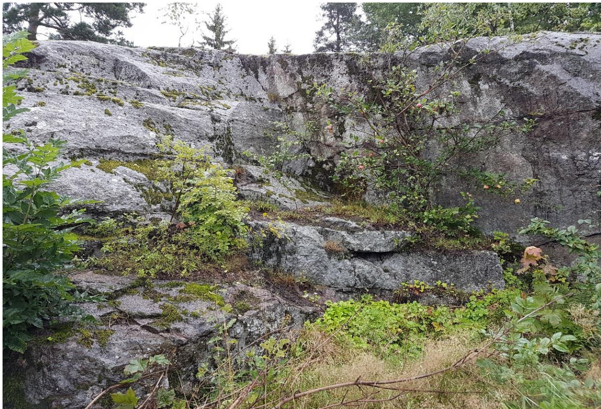
Figur 38: Bergblotning i nærhet av søndre påhugg på tunnel gjennom Hogsnesåsen.
