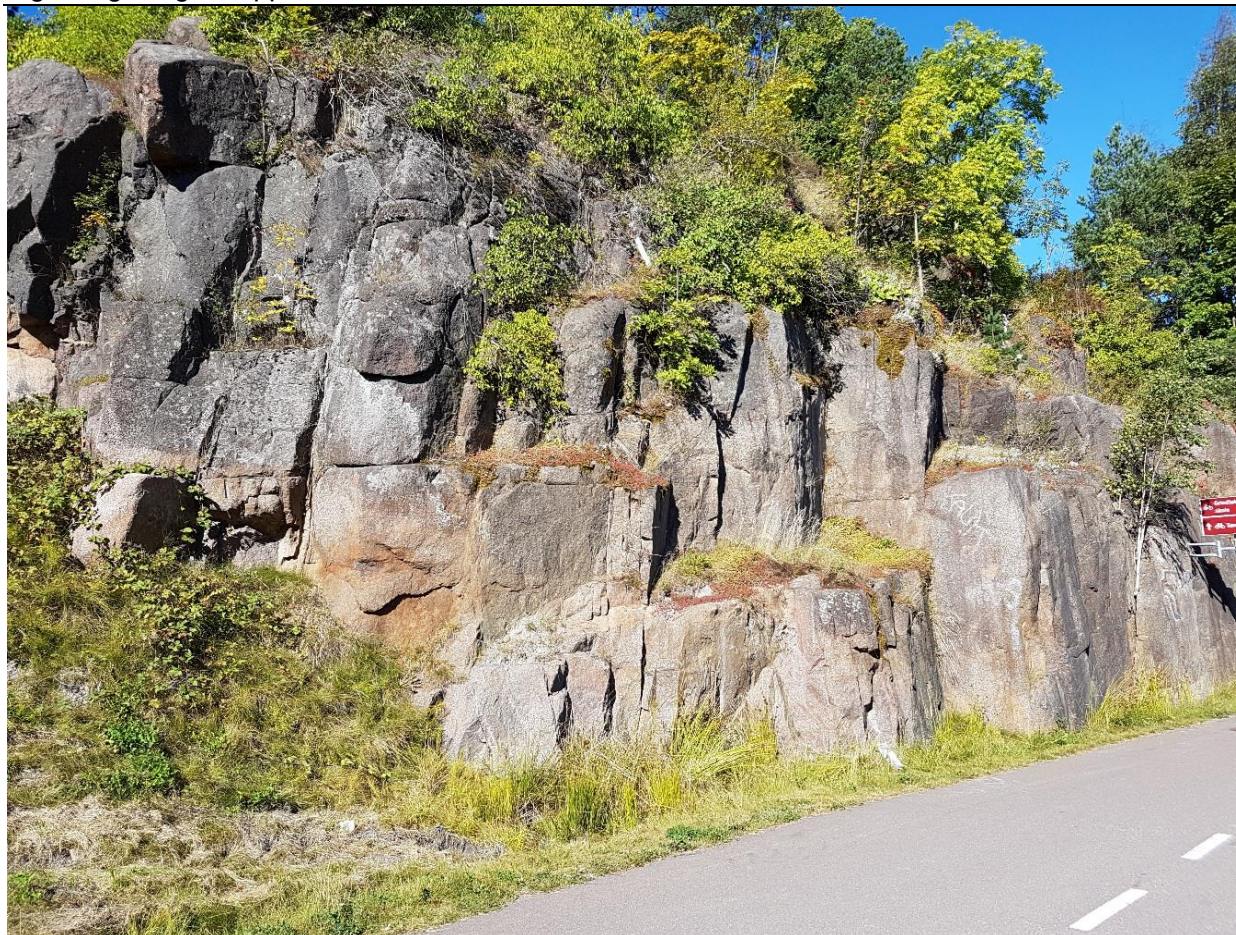
Figur 30: Søndre påhugg Kolberg profil 150, ved Kirkeveien.
