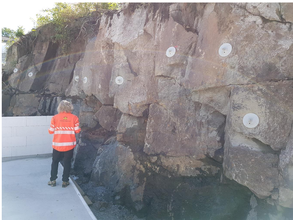
Figur 40: Bergblotning i område ovenfor Nordre påhugg.
