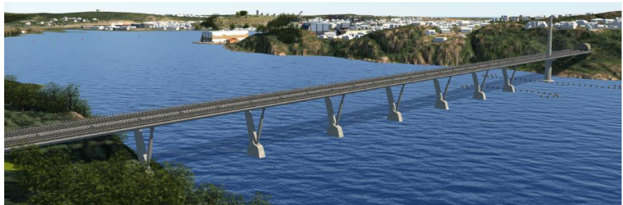
Figur 2.2: Bru over Vestfjorden med mange fundamenter i sjø (10000_D_2F)
