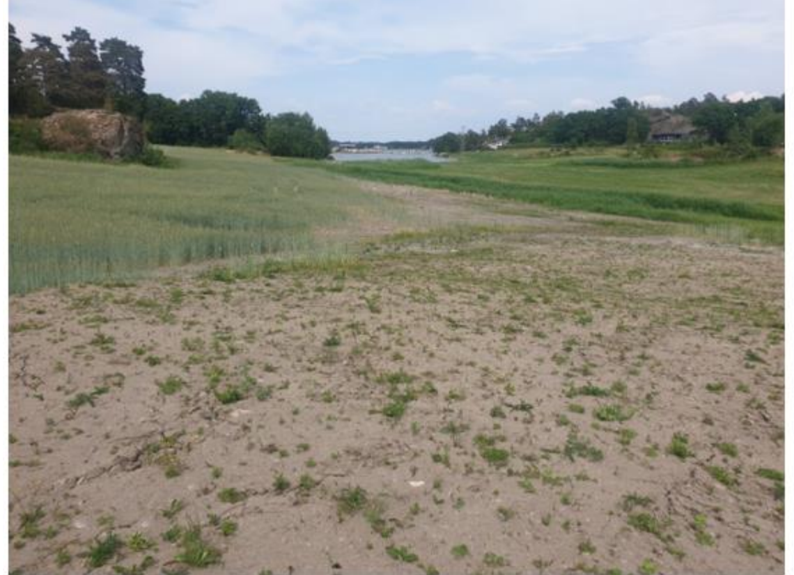
FIGUR AREALENE LANGS MED RØYSEBEKK-KILEN VAR PLANLAGT SOM MOTTAKSAREAL FOR MATJORD FRA EIKELYHAGEN. MESTEPARTEN AV MASSENE BLE FJERNET RASKT ETTER AT AREALET NEDENFOR VISTE TEGN FOR Å IKKE TÅLE VEKTEN AV MASSENE.
