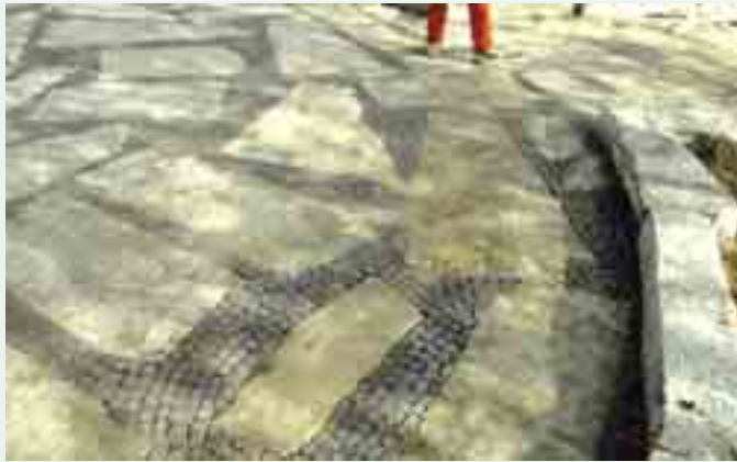
Natursteinsbelegg, bygdekarakter: Store granittplater er lagt utover i eit mosaikkmønster og fylt imellom med liten mosaikkstein. Leggemønsteret er friare
