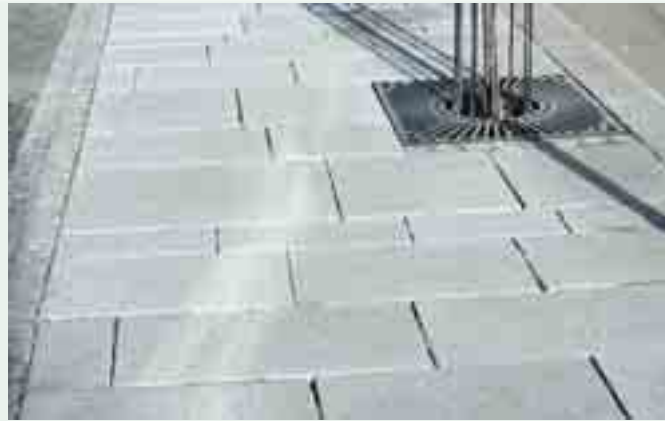
Natursteinsbelegg, bykarakter: Store rektangulære granittplater lagt i eit rettviskila leggemønster
